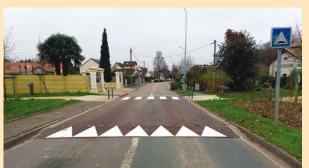
10 RUE DE VERDUN Création d'aménagements de sécurité par le Département
