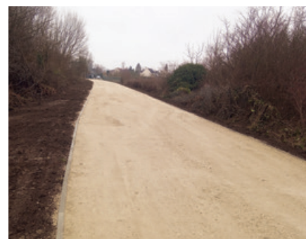
Chemin n° 5 (à proximité du collège) : élargissement
