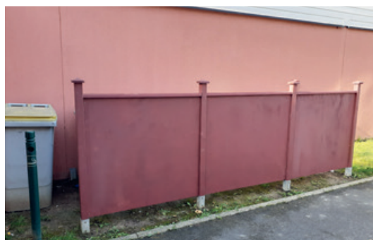
Gymnase Vibert : remise en état du local poubelle
