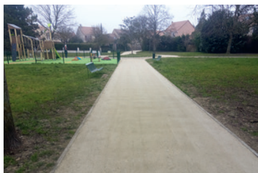
Chemin du parc (derrière l'école Maternelle) : rénovation
