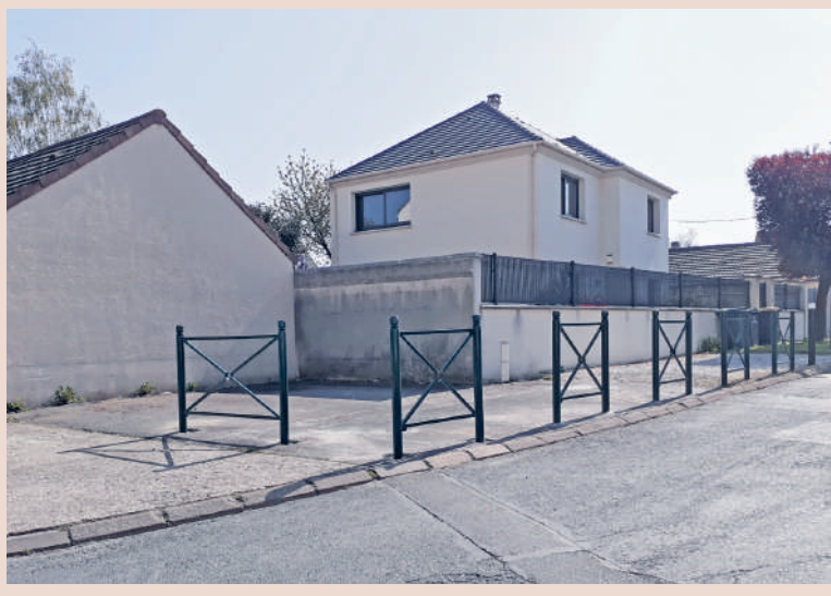
Pose des barrières à l'angle de la rue de la Croix Rouge et de la rue Pasteur.
