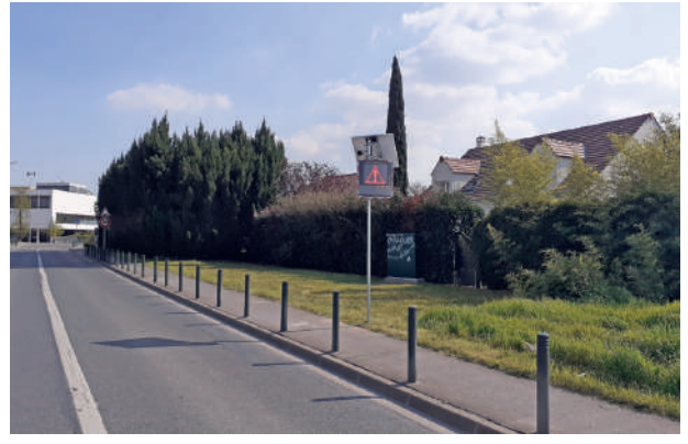
Pose du panneau pédagogique solaire rue Francois Coppée entre le collège et le panneau pédagogique solaire de contrôle de vitesse et le cimetière.
