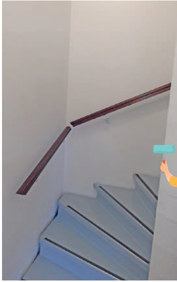
Travaux de rénovation des escaliers Salle Galopier : peinture des murs et des escaliers ainsi que la remise en état de la rampe.
