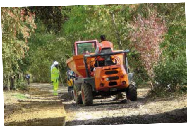
Prolongement de la Tégéval
