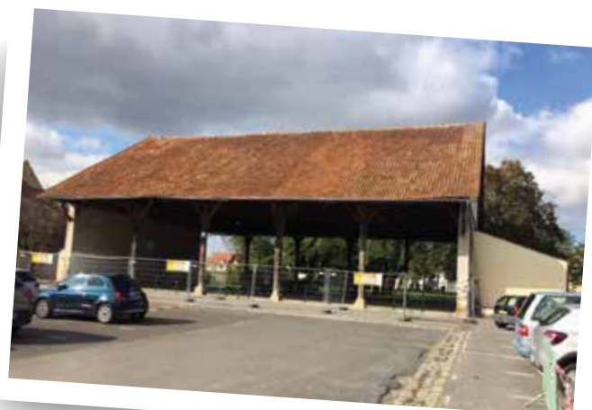
Mise en sécurité de la Halle sur la place des Tours Grises.
