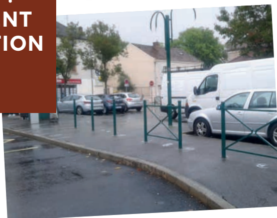
Réfection des barrières sur la place Charles De Gaulle et à ses abords.
