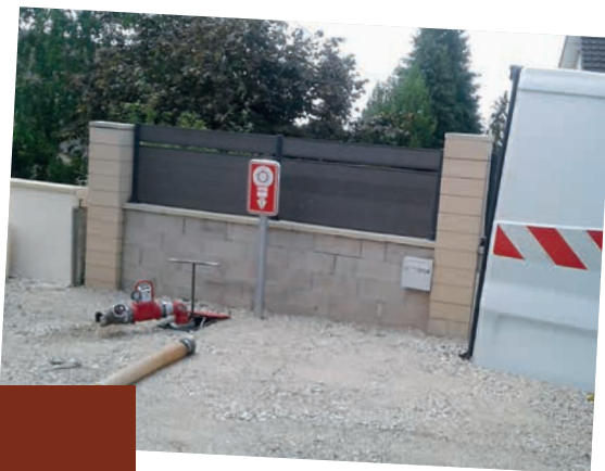
Signalisation des bouches à incendie.
