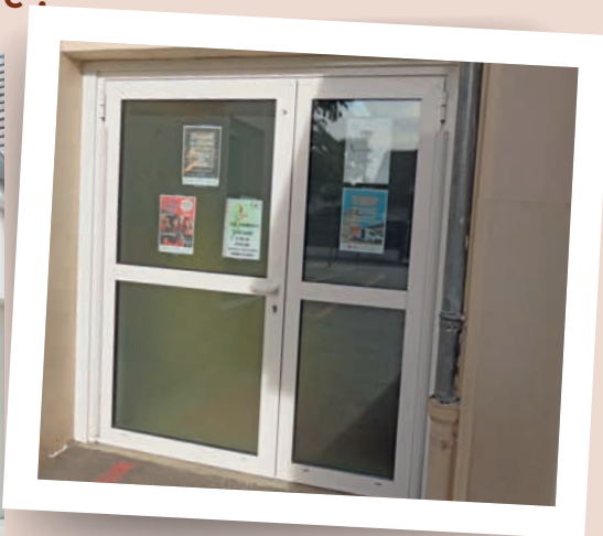
Remplacement des portes en bois par des portes en aluminium.
