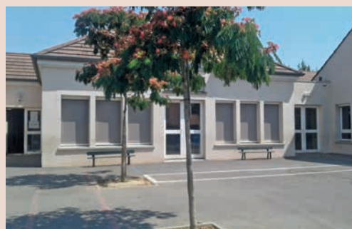
Remplacement des stores.
