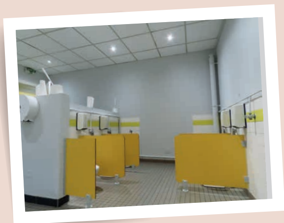
Réfection des toilettes (peinture, plafond et parois de séparation).
