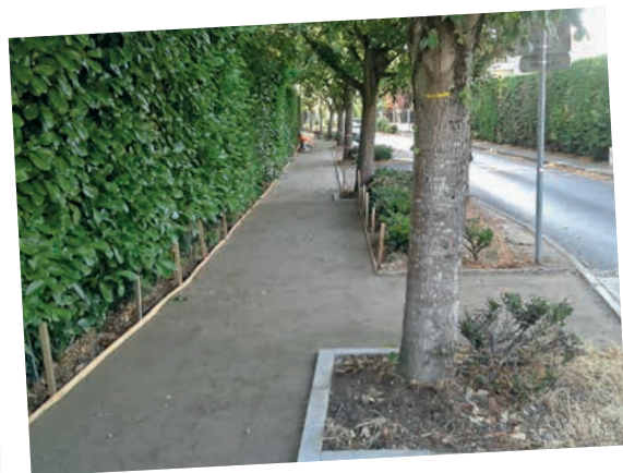
Réfection du trottoir de la rue René Thibault.
