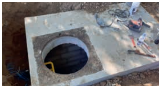
Pose d'un compteur d'eau au terrain de foot - Louis Mô
